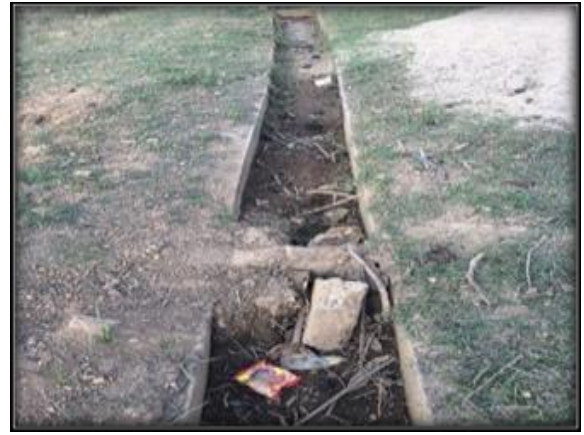
Hình 1. Kênh tưới bị vùi lấp
