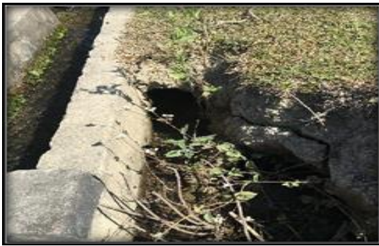
Hình 2. Sạt lở đất đắp hai bên kênh tưới
