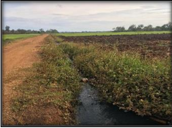
Hình 1. Kênh tưới bị vùi lấp
