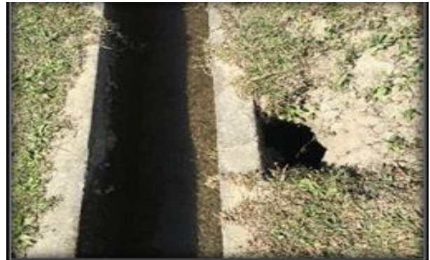
Hình 2. Sạt lở đất đắp hai bên kênh tưới
